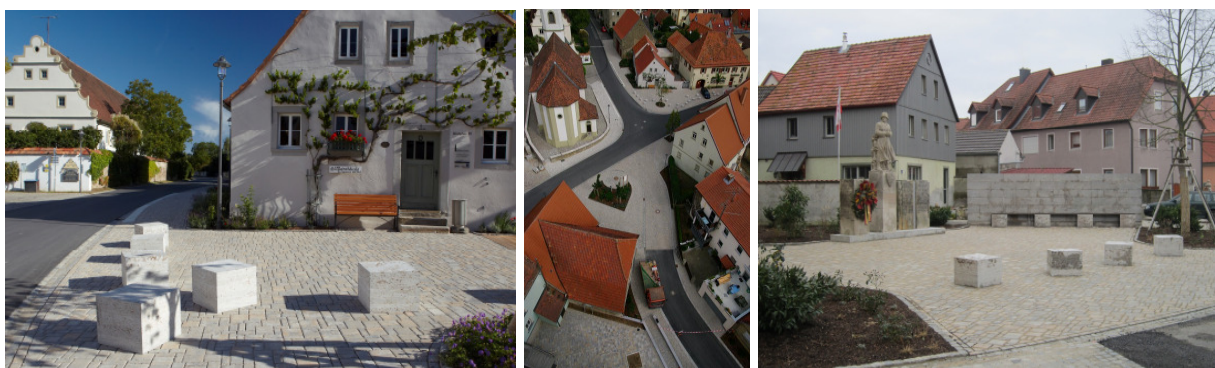
Neugestaltung Ortsmitte Fotos nach der Fertigstellung
