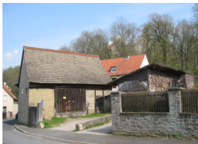
Zustand vor und nach der Sanierung
