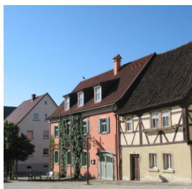
Sanierung Alte Schule vorher
