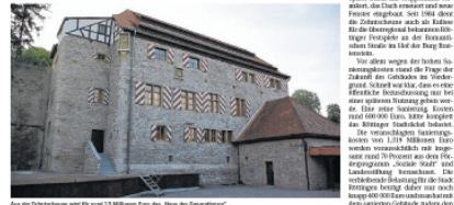
Das alte Zehntscheune wird für rund 1,3 Millionen Euro als „Haus der Generationen“ umgebaut.
