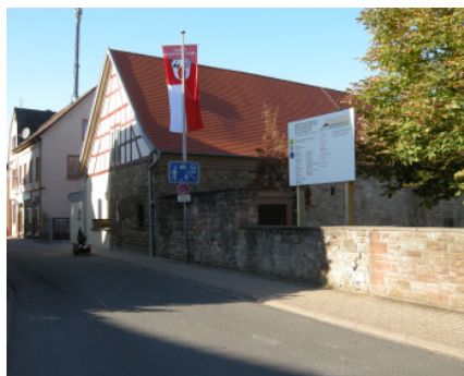
kurz vor Fertigstellung
