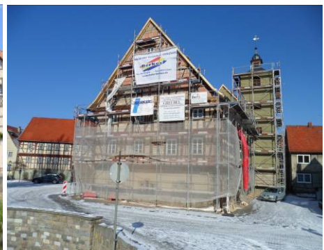
während der Bauphase © Gemeinde Nordheim v.d.R.
